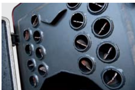
Extractor cenusa: schimbator de caldura
